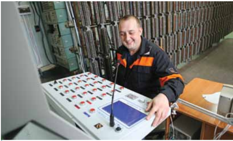
Электромонтер ЦТД Алексей Цысь проводит проверку новой системы
